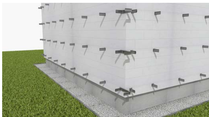
WIZ.121.1. Montaż konsoli do ściany.
